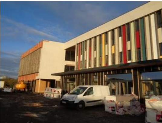
Travaux de bâtiments à ossature bois
