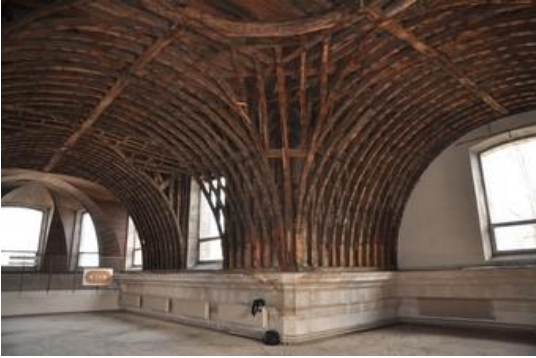
Travaux de réhabilitations
