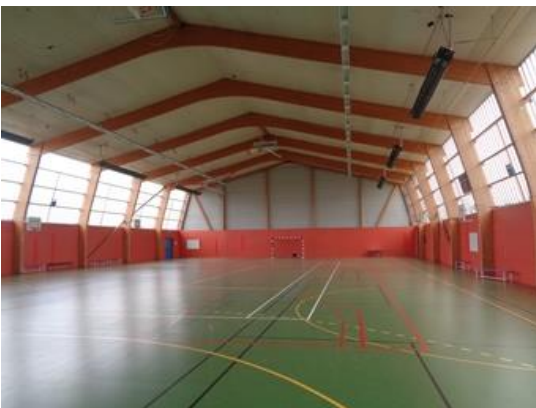
Diagnostic de charpentes lamellées collées
