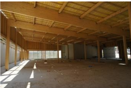
Travaux de charpentes lamellées collées
